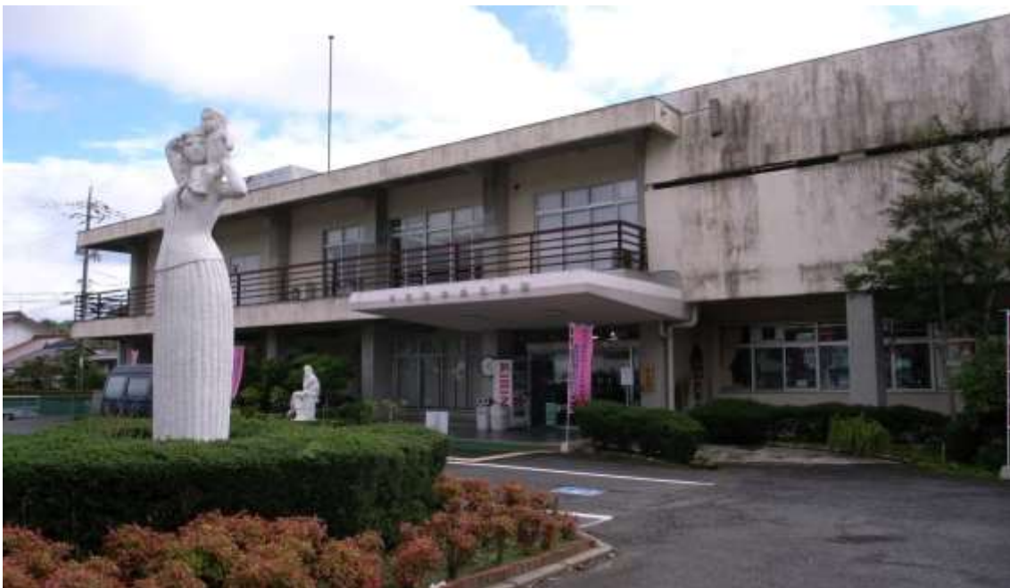
現在の千代田中央公民館（昭和 46 年建設）
