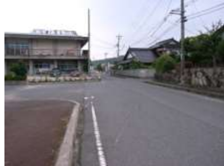
拡幅が必要な町道河本中出線
