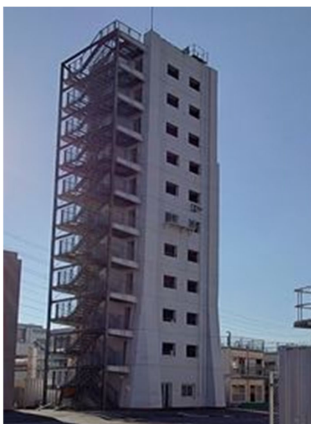
図 4.2.3 消防大学校訓練塔 (2022.12.9 撮影)
