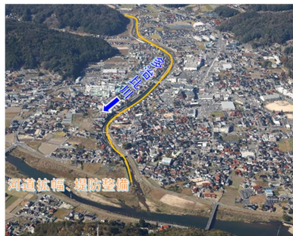
図 4-3 河川改修箇所（安芸高田市：多治比川）
