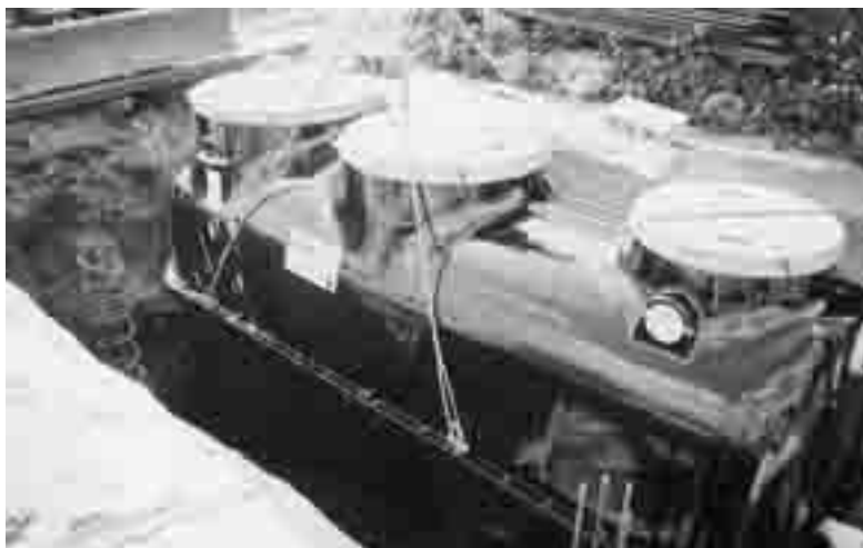
小型合併処理浄化槽の設置状況
