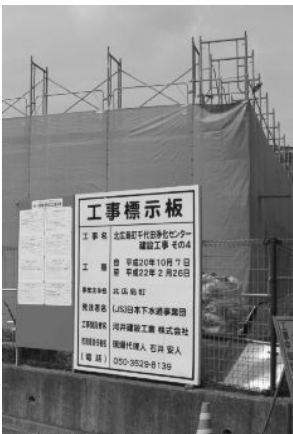
建設中の六億六〇〇万円の浄化センター
