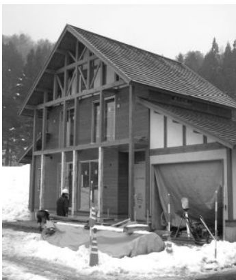
▲建設中の若者定住促進住宅(雄鹿原)
