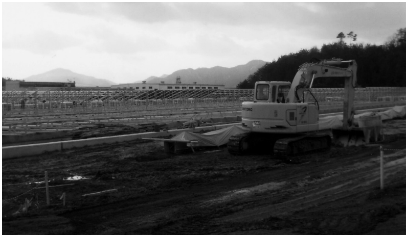
メガソーラー工事中の氏神工業団地
