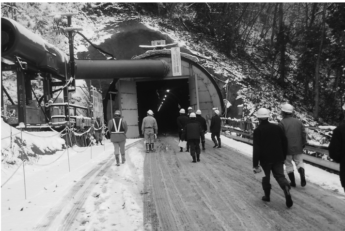
芸北トンネル入り口(豊平側)
