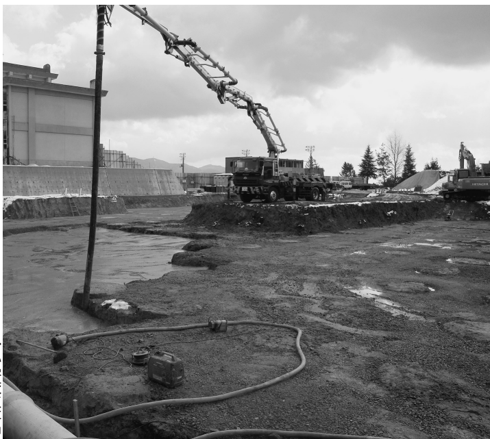
→小学校工事中
