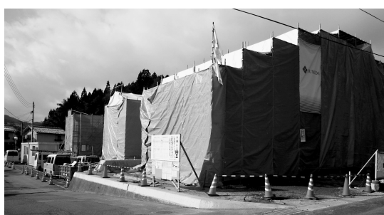
↑建設中の若者定住促進住宅(志路原団地)
