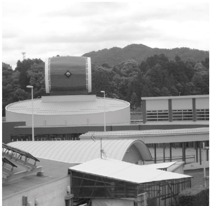
▲工事が進む道の駅舞ロードIC千代田
