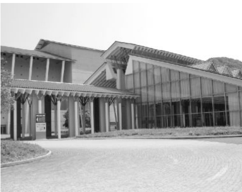
▲サウンド・ア・ミュージアム温泉プール外観
