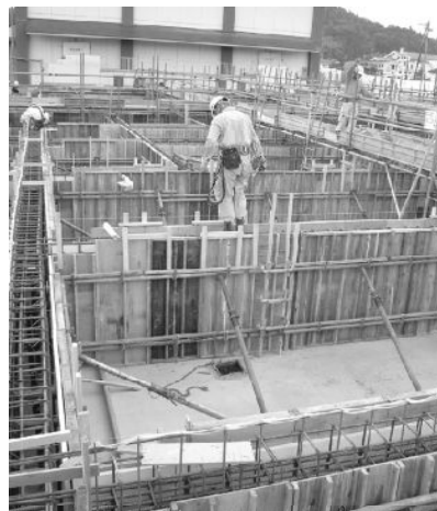
▲建設中の壬生小学校
