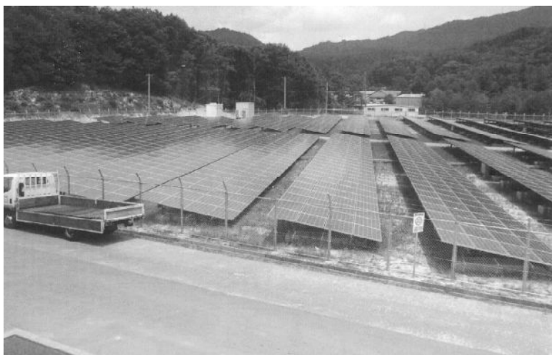
▶豊平地域にオープンした太陽光発電施設
