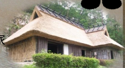
修復前の樽床民家
