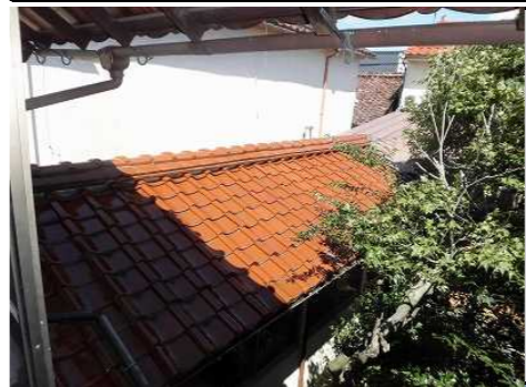
屋根瓦棒葺き
