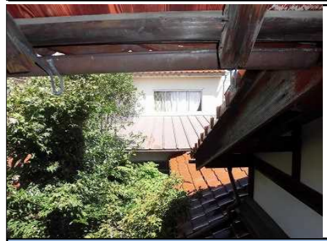
屋根瓦棒葺き
