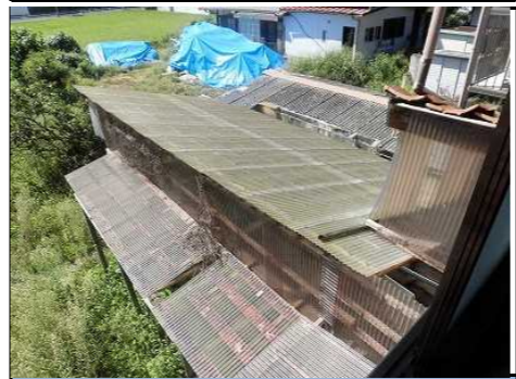
屋根ビニール波板張り通路南側
