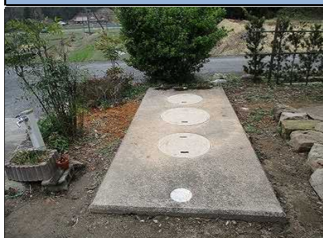
浄化槽設置状況
