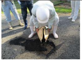
③合材をいれ、スコップなどでならす。車の重みなどで沈むので、合材は少し多めに入れるのがポイント。
