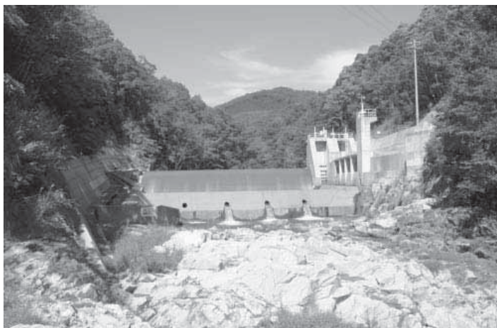
▲水の力で電気をつくる川小田発電所
