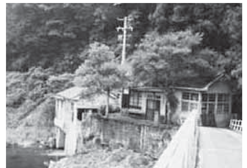
壬生発電所（千代田） 【広島北部農業協同組合】
