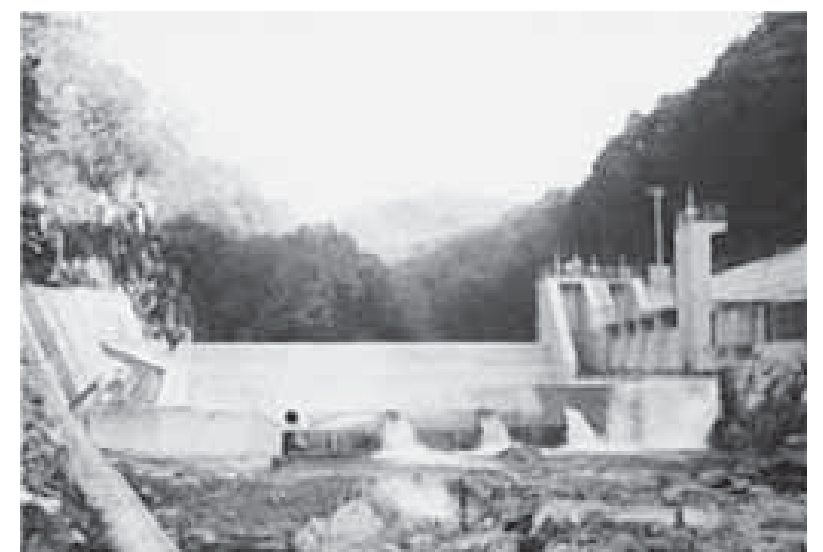
川小田発電所（芸北）
