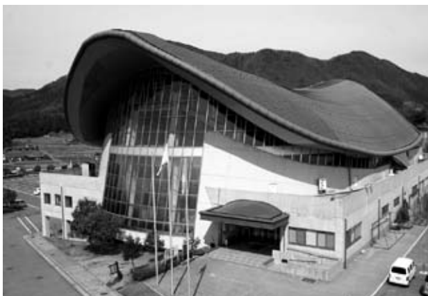
豊平総合運動公園体育館
