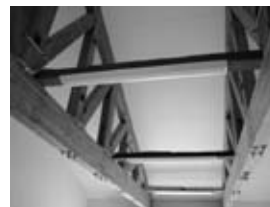
倉庫の照明取付梁に使用した旧大塚小学校の再生材
