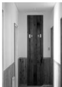
廊下突当りの壁に使用した旧大塚小学校の再生材
