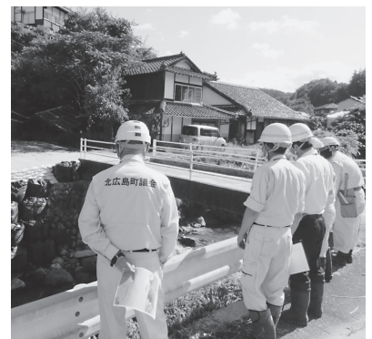
建設課職員から被災箇所の説明を受ける
