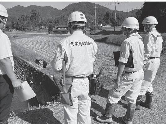
建設課職員から被災箇所の説明を受ける
