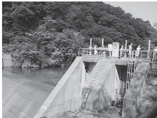
②取水ダム全景
