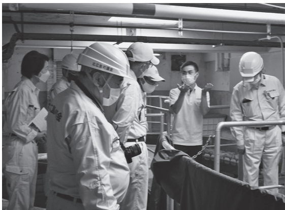
老朽化の実地を確認
