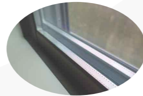
住宅の断熱改修
