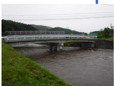
八幡橋 L=25.8m (R C 橋) 1933 年架設
