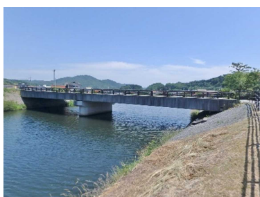
新庄大橋 L=44.0m (P C 橋) 2002 年架設
