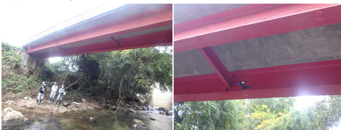
橋梁定期点検状況
