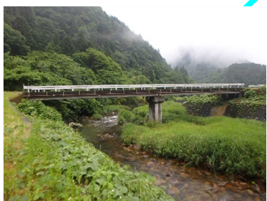
念佛橋 L=37.4m (P C 橋) 1989 年架設
