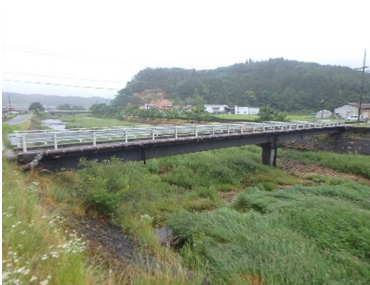
落合橋 L=50.0m (鋼橋) 1983 年架設
