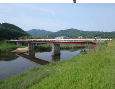
川井大橋 L=87.4m (鋼橋) 1975 年架設
