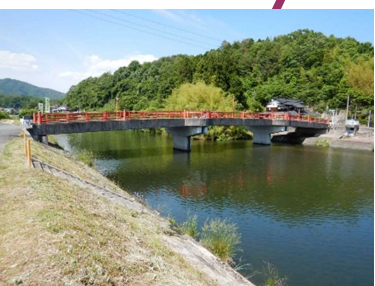
古保利橋 L=62.5m (P C 橋) 1998 年架設
