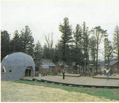
▲ボードデッキ棟
