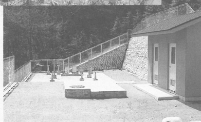
▲雲月地区簡易水道浄水場
