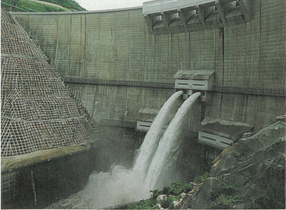
▲常時満水位到達時の試験放流のようす。
