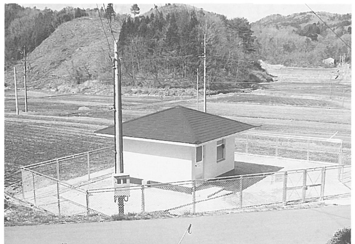
▼美和東地区簡易水道 枕ポンプ場
