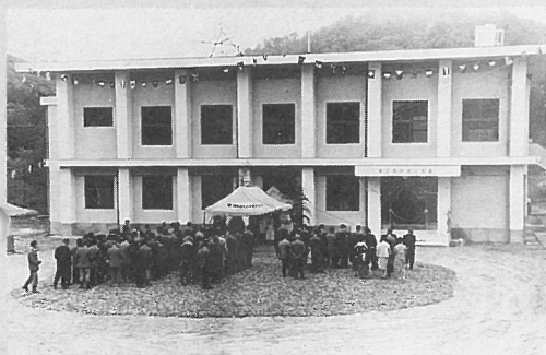
▲ S39.6.13 芸北町中央公民館竣工式
