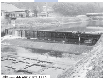
青木井堰(冠川)
