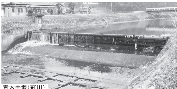
青木井堰(冠川)
