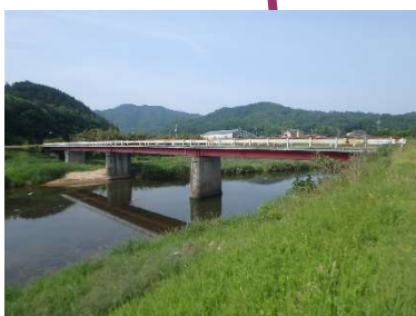
川井大橋 L=87.4m (鋼橋) 1975 年架設
