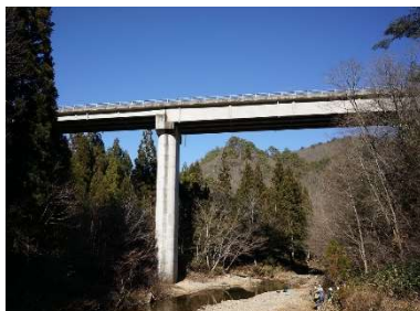
鎧滝橋 L=112.0m (P C 橋) 1985 年架設
