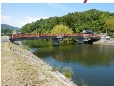
古保利橋 L=62.5m (P C 橋) 1998 年架設
