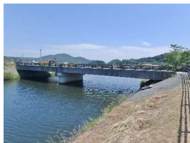
新庄大橋 L=44.0m (P C 橋) 2002 年架設
