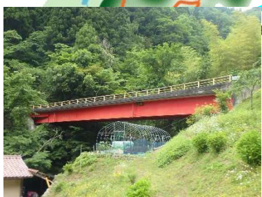
新神才橋 L=37.3m (鋼橋) 1980 年架設
