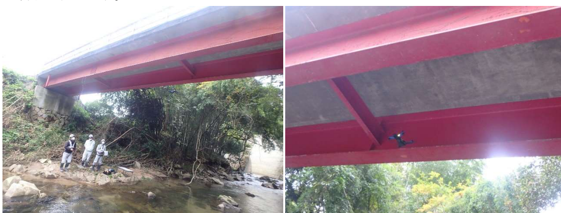
橋梁定期点検状況
