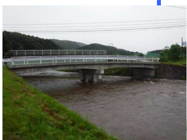
八幡橋 L=25.8m (R C 橋) 1933 年架設
