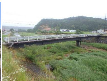
落合橋 L=50.0m (鋼橋) 1983 年架設
