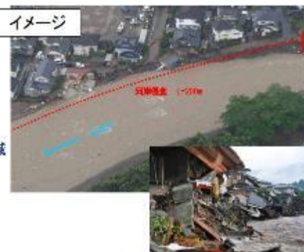
河岸侵食により家屋倒壊した状況
