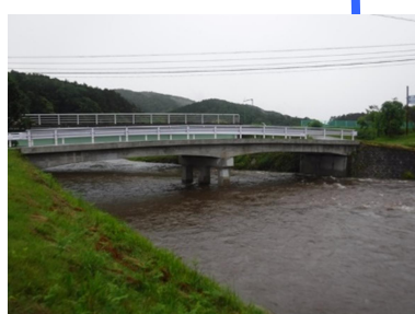
八幡橋 L=25.8m (RC橋) 1933 年架設
