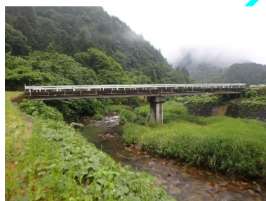
念佛橋 L=37.4m (P C 橋) 1989 年架設
