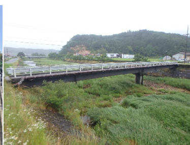
落合橋 L=50.0m (鋼橋) 1983 年架設
