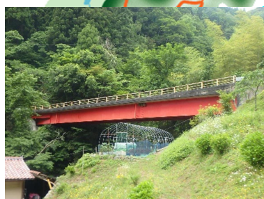
新神才橋 L=37.3m (鋼橋) 1980 年架設
