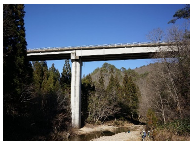
鎧滝橋 L=112.0m (P C 橋) 1985 年架設
