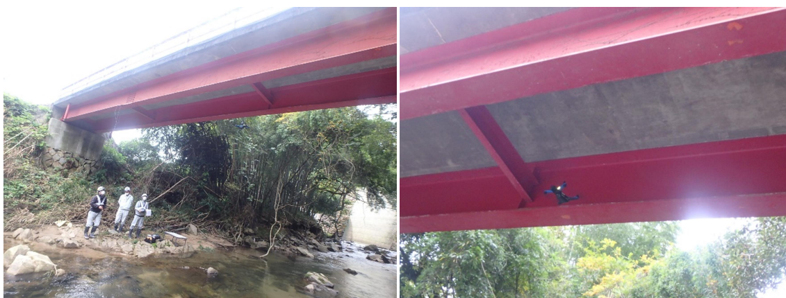
橋梁定期点検状況
