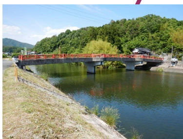
古保利橋 L=62.5m (P C 橋) 1998 年架設
