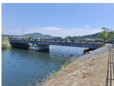
新庄大橋 L=44.0m (P C 橋) 2002 年架設
