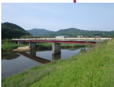
川井大橋 L=87.4m(鋼橋) 1975 年架設
