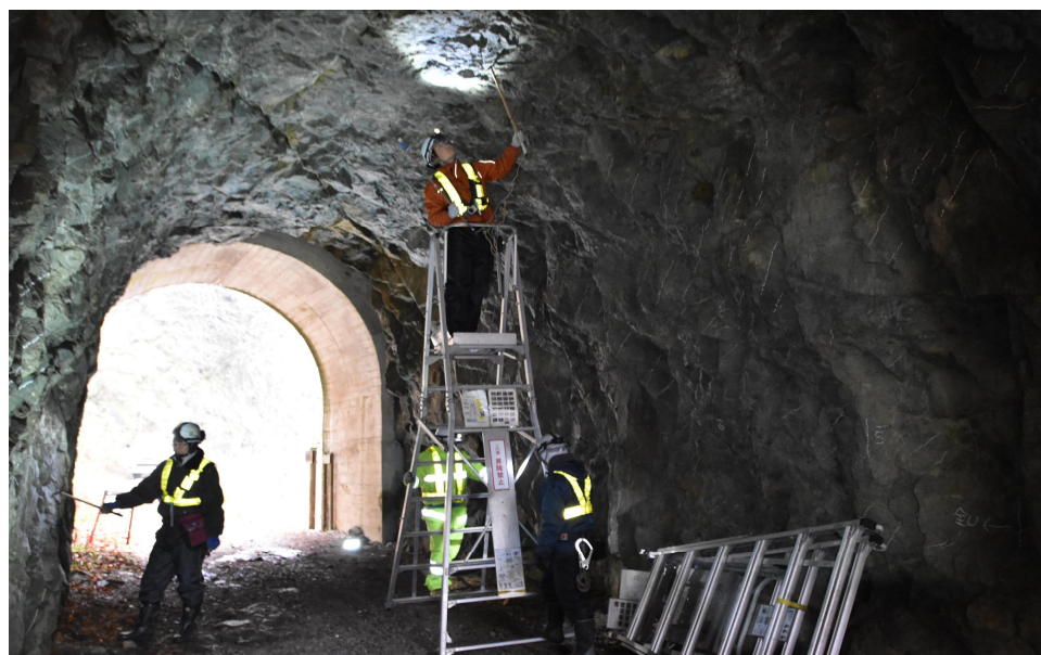
図 1-3 トンネル定期点検状況（令和元年度）
