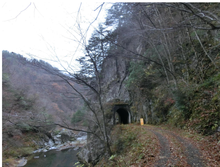
図1-2 北広島町が管理するトンネル
