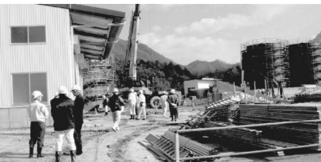
◀ 建設中の喜楽鉱業株
