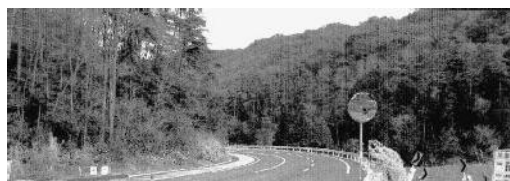
▲ 開通間近となった県道七曲千代田線
