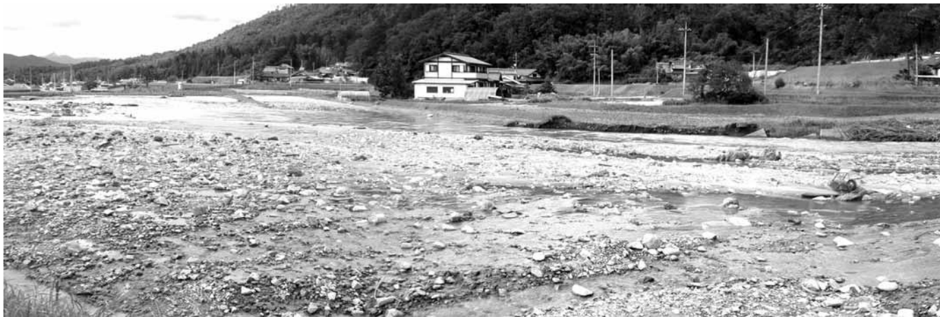
▲一級河川出原川(さいの河川と化した南方中原地区)
