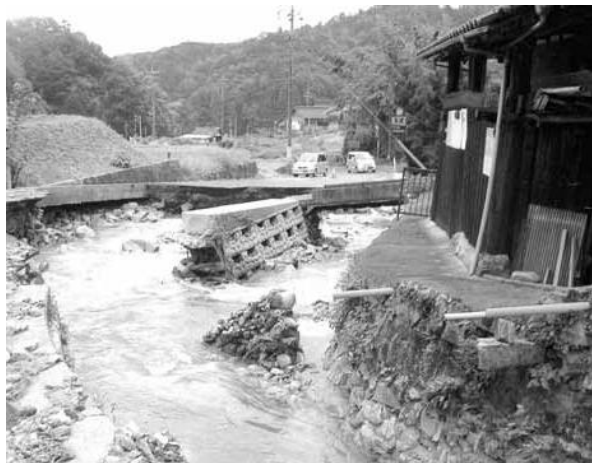
▲通行不能となった県道千代田八千代線(南方畑地区)
