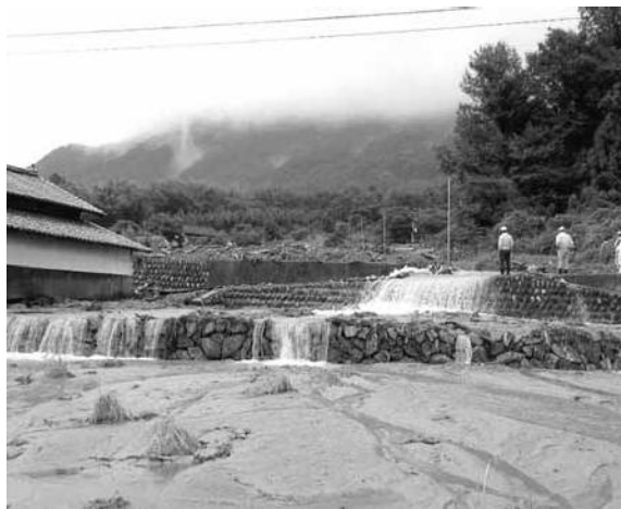
▲土石流発生の本地地区
