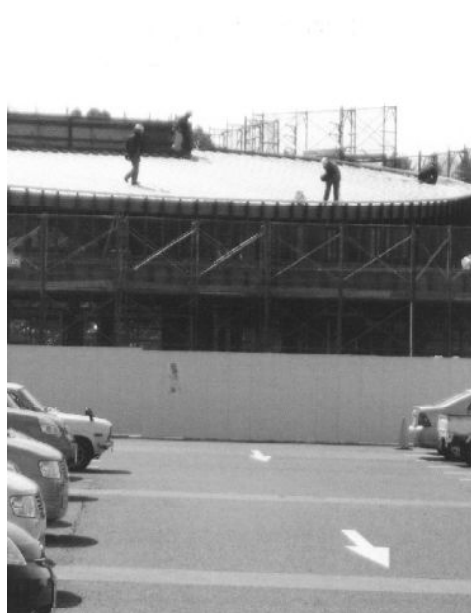
▶ 工事が進む道の駅
