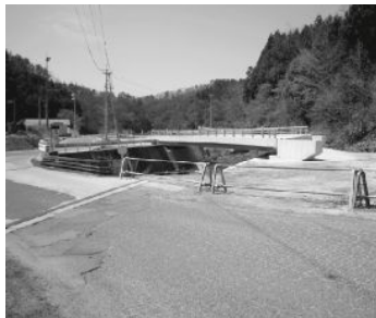
▶大島橋架け替え工事(吉木地区)
