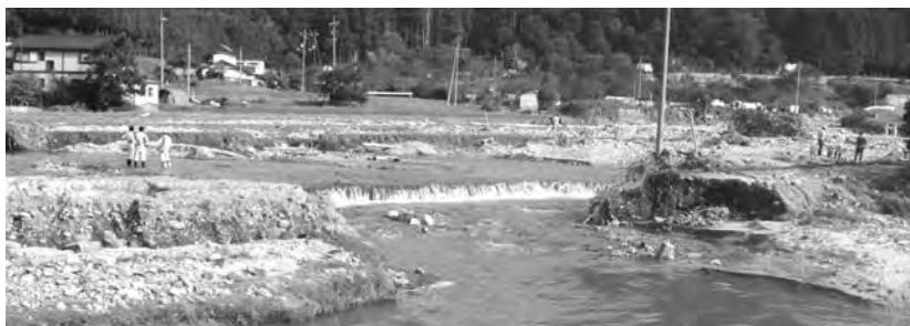
▶ 南方出原川護岸崩壊 (平成18年9月)
