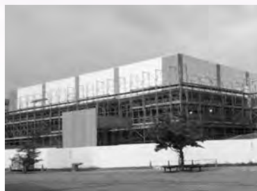
▲工事中の町民温水プール
