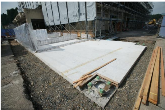
耐圧版完了状況
