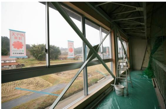
南面外壁耐震補強完了
