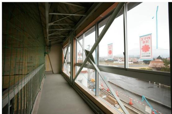
北面外壁耐震補強完了
