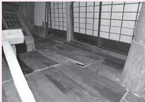
◀ 修復前の古民家の床材
