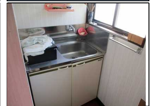
別棟 2階 湯沸室
