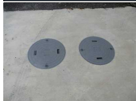
浄化槽設置状況
