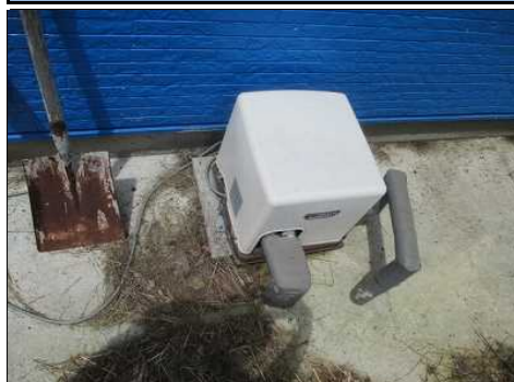
ポンプ設置状況
