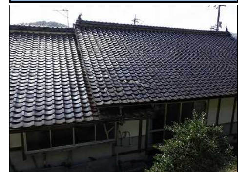
屋根 石州瓦葺き状況
