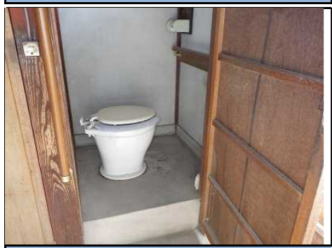
トイレ汲み取り (通路)
