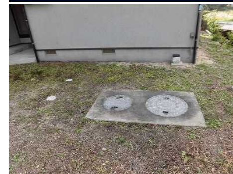
浄化槽設置状況
