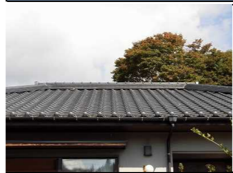
屋根施工状況
