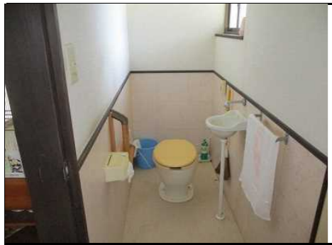
トイレ汲み取り
