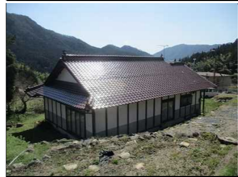
主屋 外観 北側
