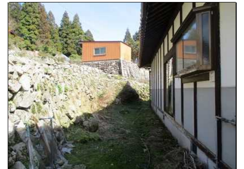
主屋 外観 北側
