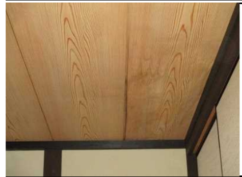
天井状況一部
