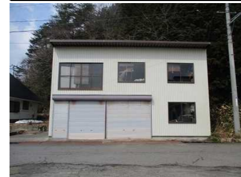
鉄骨造2階建倉庫
