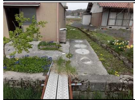
浄化槽設置状況
