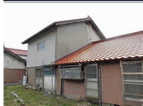
外壁補修部分
