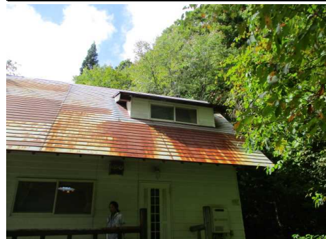
外観 屋根状況
