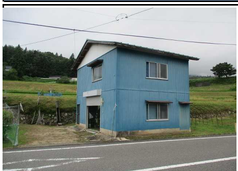
外観 別棟 東側
