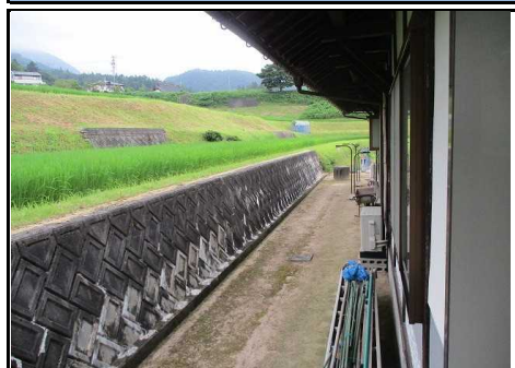
西側ブロック積み
