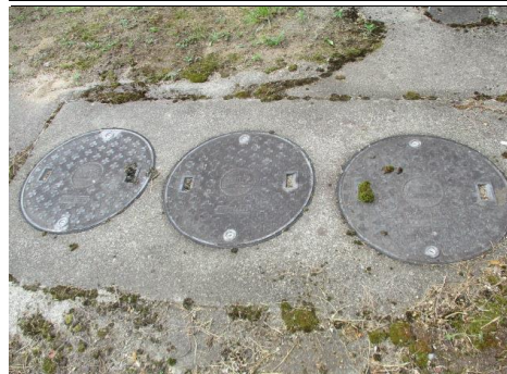
浄化槽設置状況
