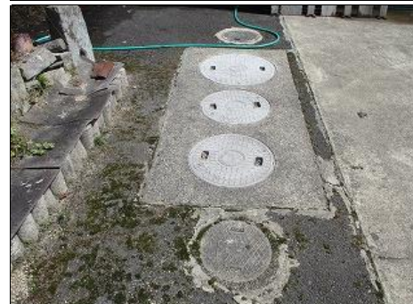
浄化槽設置状況
