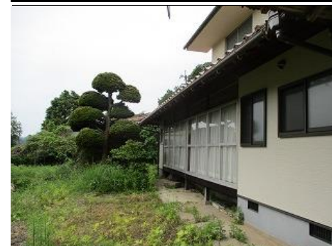
主屋 外観 東側
